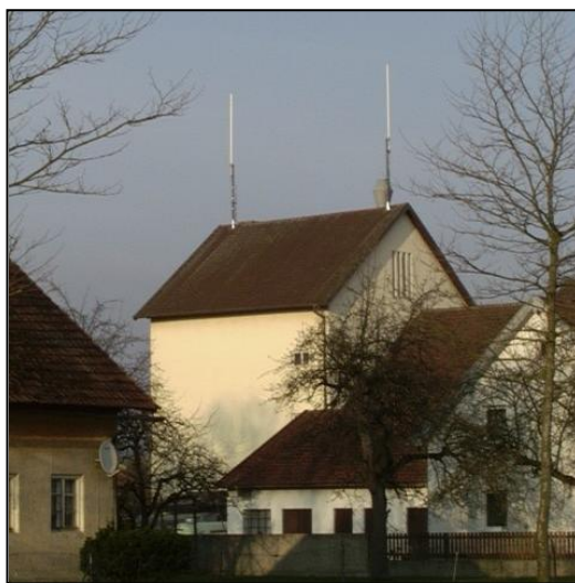
Abb. 1: Beispiel für eine Mobilfunksendeanlage mit omnidirektionalen Antennen.
