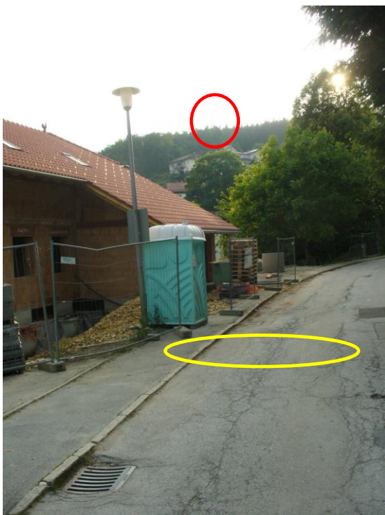
Bild 6: Messpunkt 5 mit Anlagenstandort im Hintergrund
